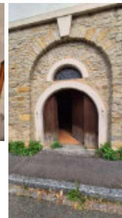
Eingang zum Keller. Eine großzügig verglaste Eingangstür würde Licht in den Keller bringen.
